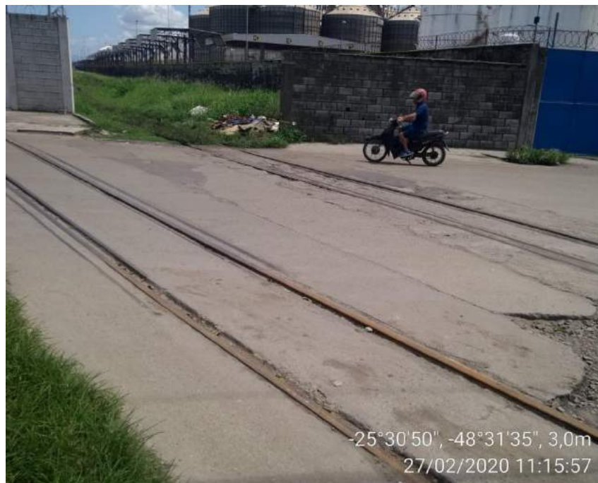
Figura 60: Passagem de nível na Rua José Cadilhe.
