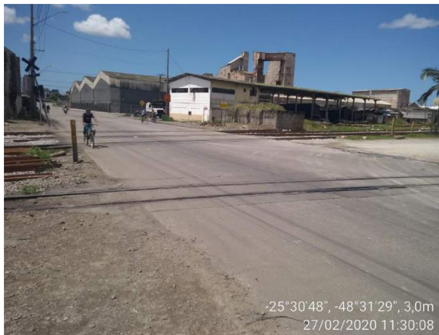
Figura 61: Passagem de nível na Avenida Coronel Santa Rita.
