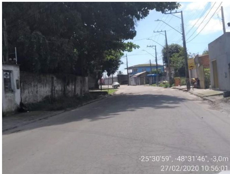
Figura 51: Rede de iluminação na rua José Cadilhe.
