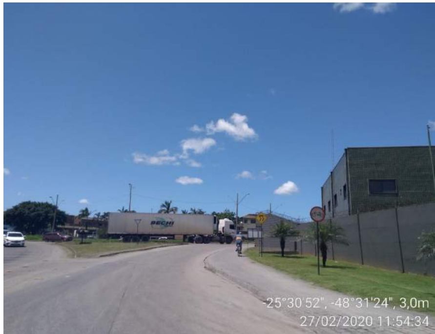
Figura 67: Área/Ponto Crítico 02: Rotatória da Av. Coronel Santa Rita com Av. Ayrton Senna da Silva.
